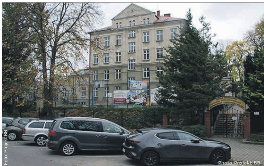
Budynek szkolny wzniesiony przez siostry w 1909 r. – widok od strony ul. Broniewskiego.
