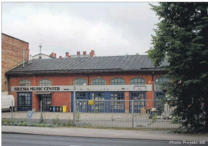
Budynek dawnej zajezdni tramwajowej w 2023 r.
